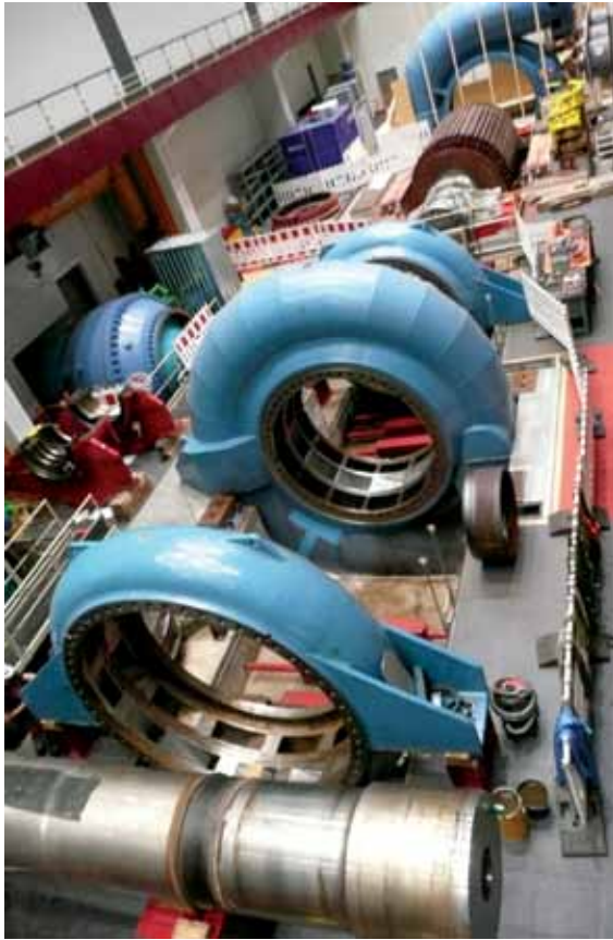
Kraftwerk Wehr: Revision Maschine A10
