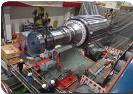
Kraftwerk Wehr: Herabsenken des Rotors auf die Unterhälfte des Generatorstators
