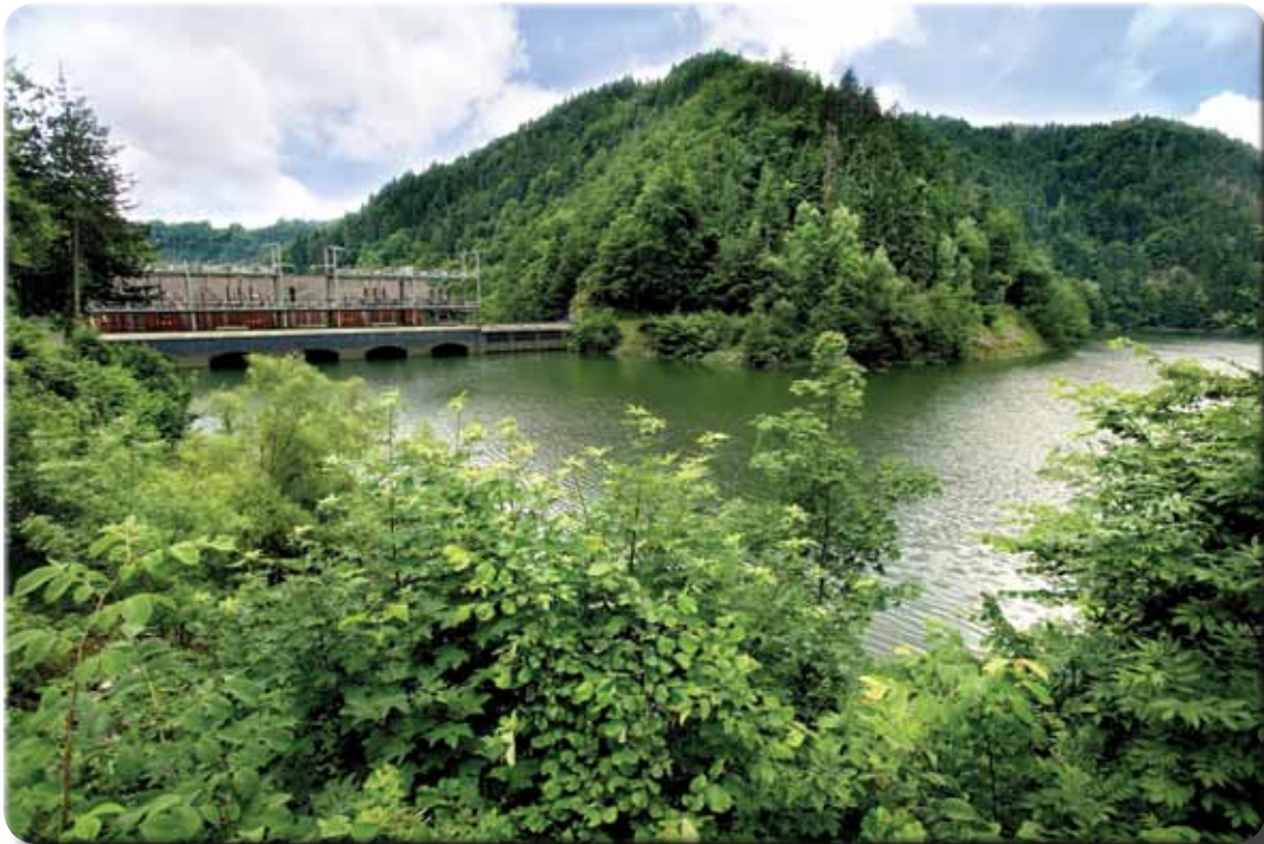
Kraftwerk Witznau: Witznaubecken und Staumauer
