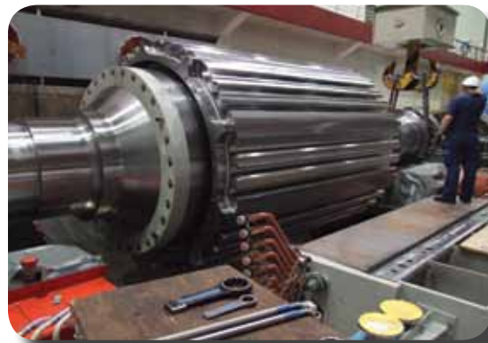
Kraftwerk Wehr: Rotor in Unterhälfte Generatorstator eingelegt
