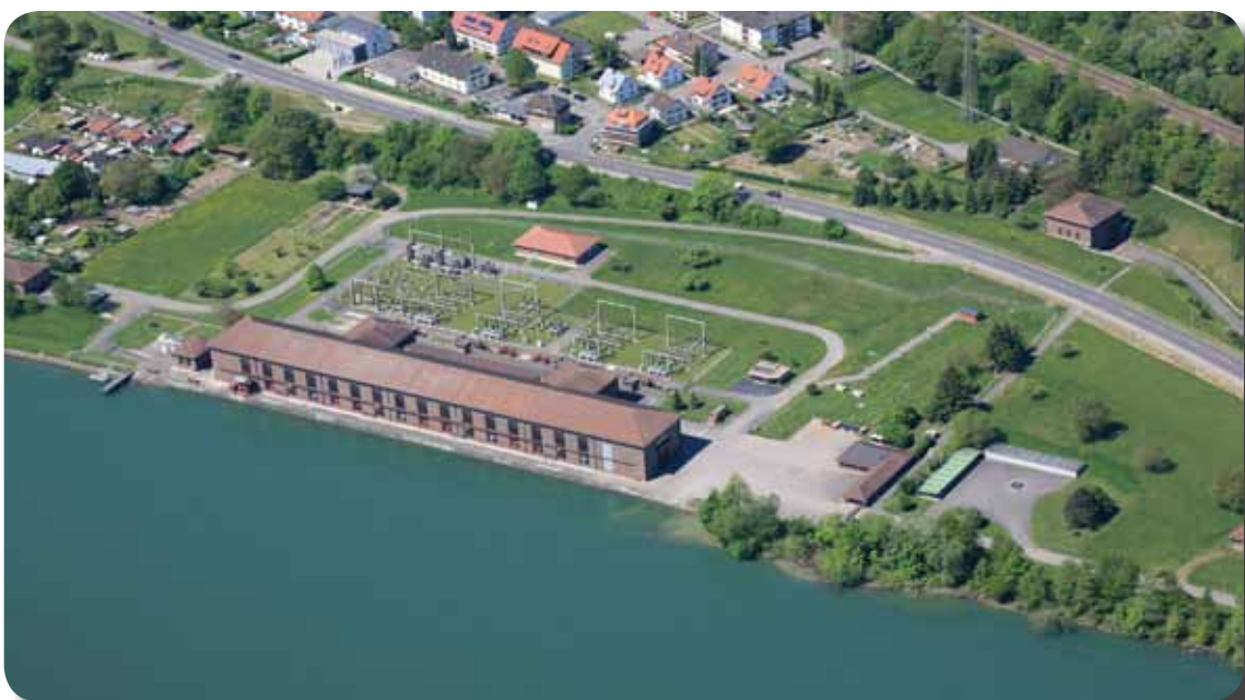
Kraftwerk Waldshut: Kraftwerksanlage von oben
