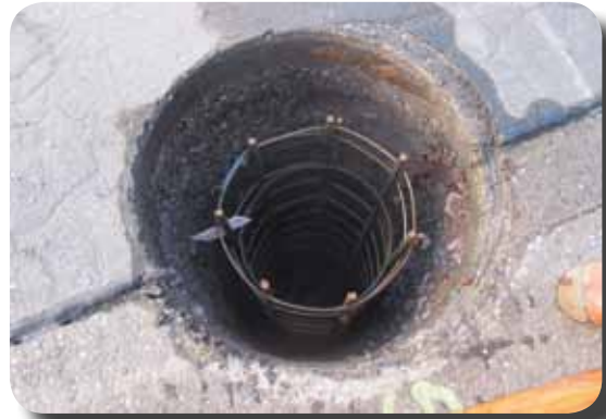
Bohrpfähle Bewehrung
