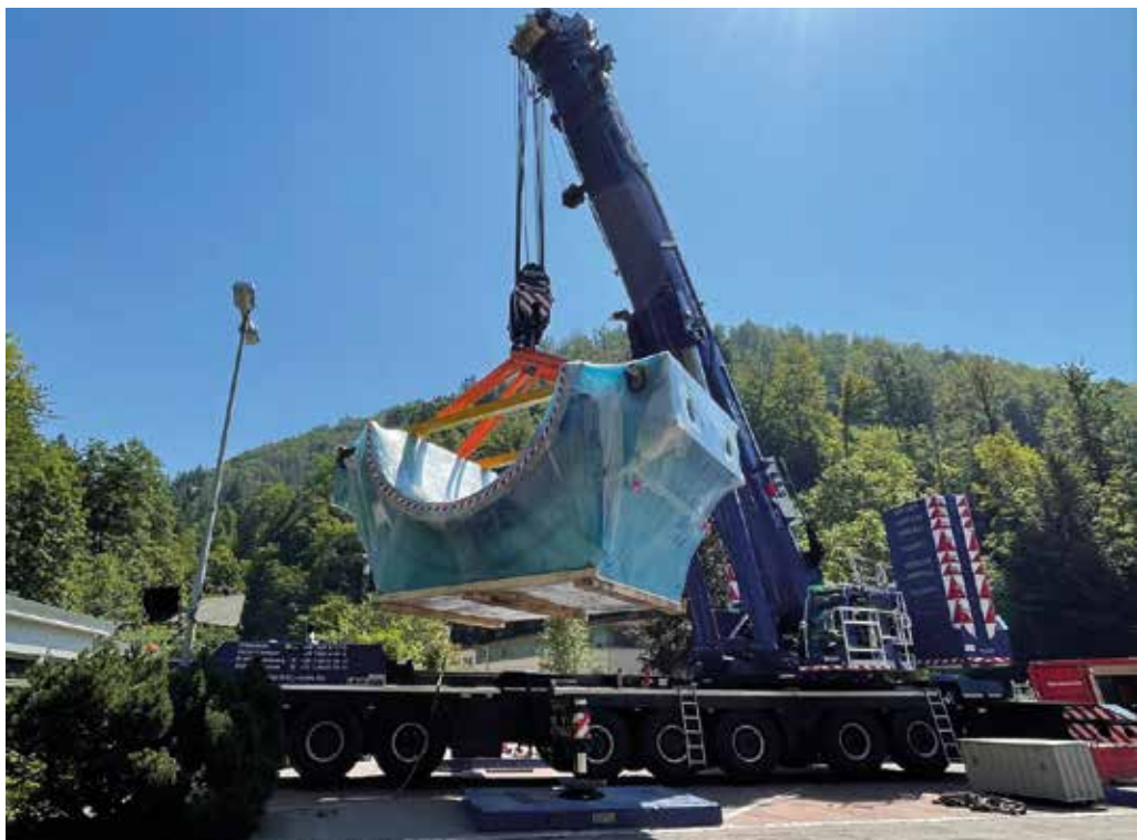
Kraftwerk Wehr - Anlieferung Stator B9
