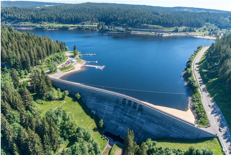
Der Schluchsee: Deutschlands größter Energie- und Stromspeicher
