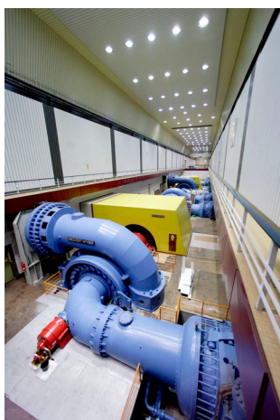
BU: Kaverne Kraftwerk Wehr
