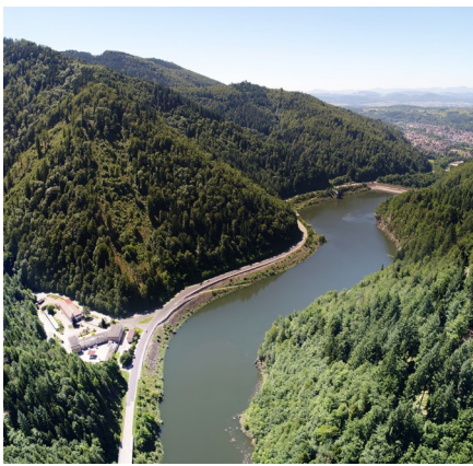
BU: Luftaufnahme Betriebsgelände Kavernenkraftwerk Wehr und Wehrabecken
