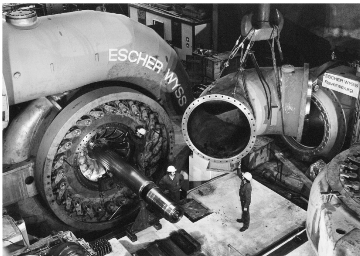
Bild 2: Montage des Saugkrümmers an einer der vier Francis-Spiralturbinen des Pumpspeichers Wehr.
